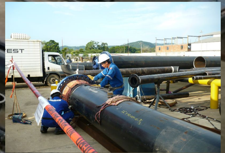
Bridas y válvulas de tubería de Ø 36"
