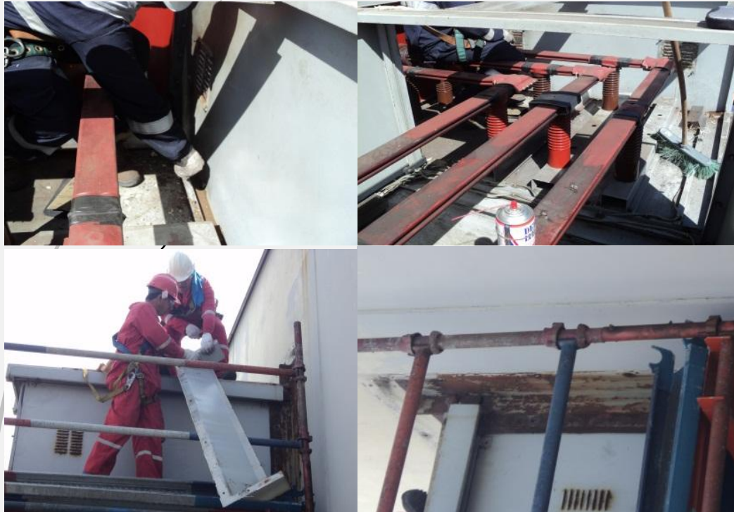
Reacondicionamiento de Ductos y Sistemas de Calefacción en Conductores de Barras de 34.5 K
